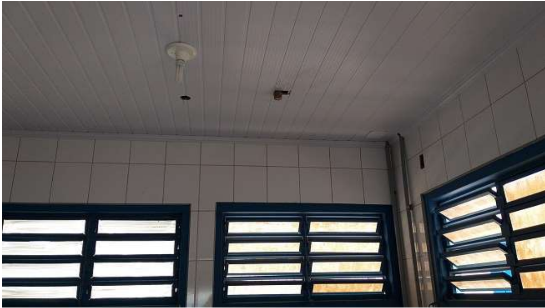
Figura 40 – Tubulação para instalação de lavadora industrial
