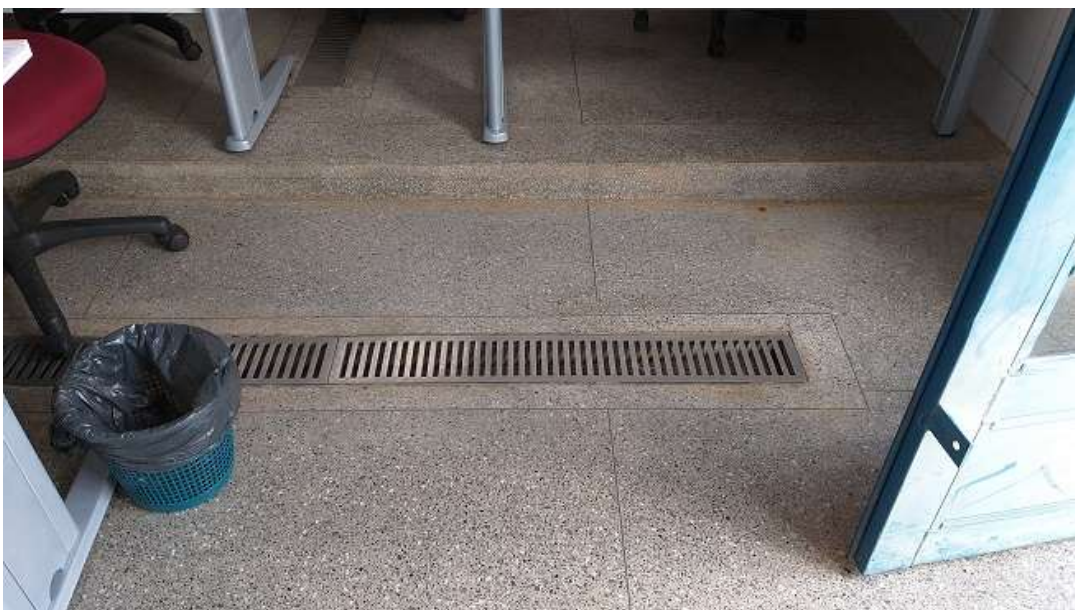
Figura 39 – Grelhas e desníveis de piso
