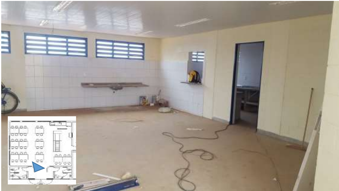
Figura 32 – Vista do espaço que abrigaria o refeitório
