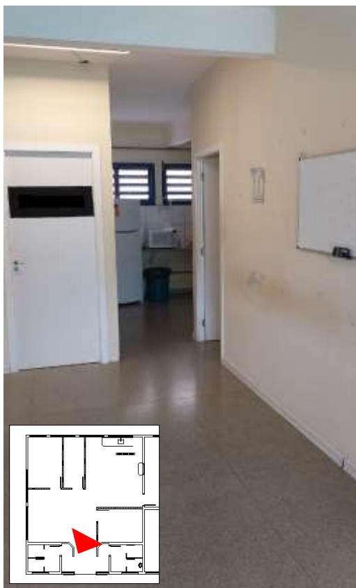
Figura 33 – Refeitório alterado – Vista 1
